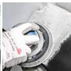
Brúsenie na dosiahnutie hladkého povrchu
